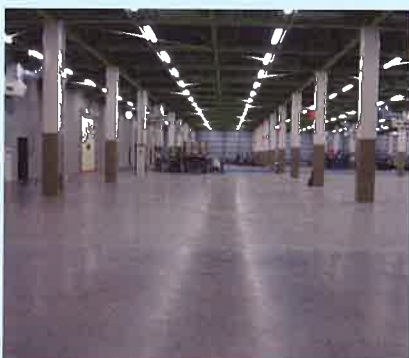
愛知県・自動車部品工場床塗装工事
