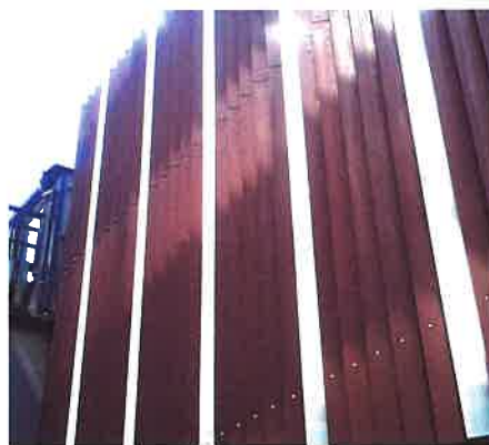
東京都・金沢ビルルーバー
