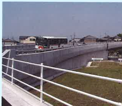
愛知県・春日井市松本跨道橋
